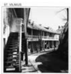
Tilto gatvės Nr. 12 kiemas.
